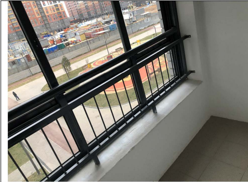
Фото №7. Общий вид лоджии в квартире.
