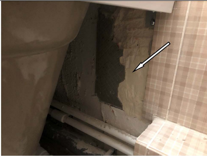
Фото №61. Частично не хватает настенной керамической плитки в ванной комнате в квартире.
