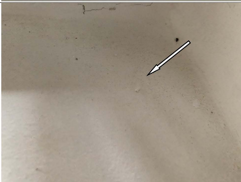
Фото №39. Неровности, сколы на окрашенных откосах оконного блока ПВХ в кухне в квартире.
