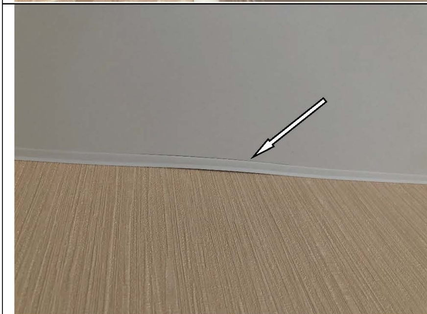
Фото №23. Дефект вставки гибкой вставки натяжного потолка в спальне в квартире.
