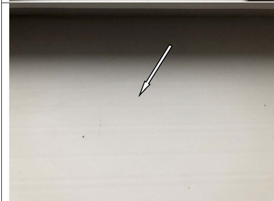
Фото №27. Царапина на подоконной доске в детской в квартире.
