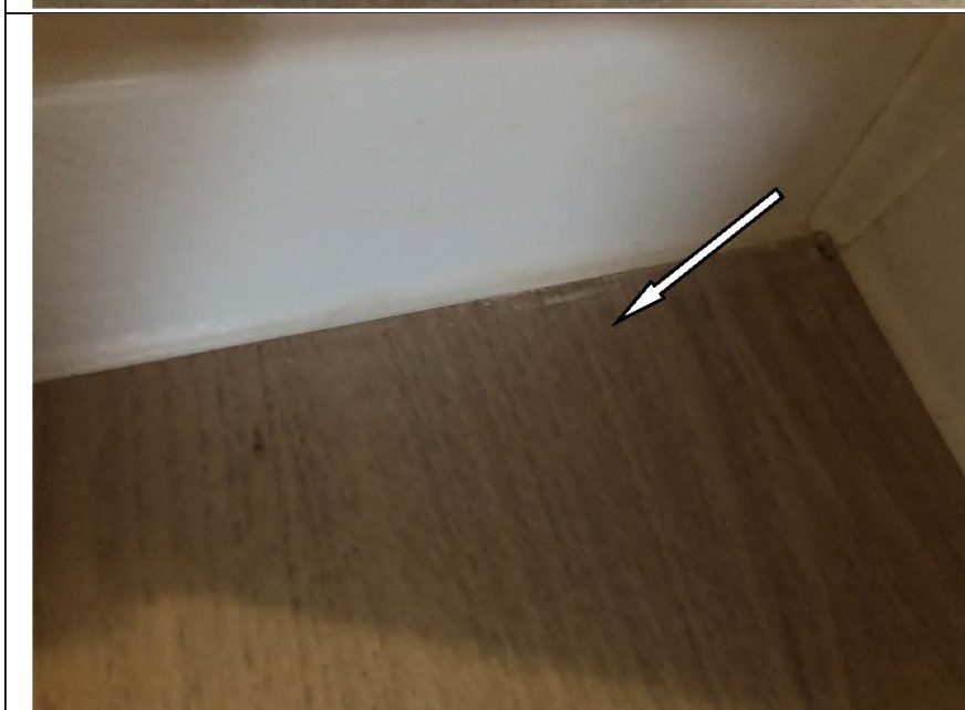
Фото №66. Прогиб ламината в коридоре в квартире.
