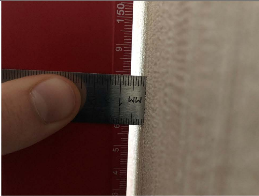
Фото №10. Измерение стен кухни в квартире.
