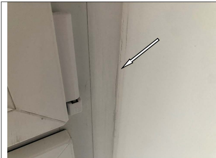
Фото №31. Инfiltrация оконного блока ПВХ в спальне в квартире.
