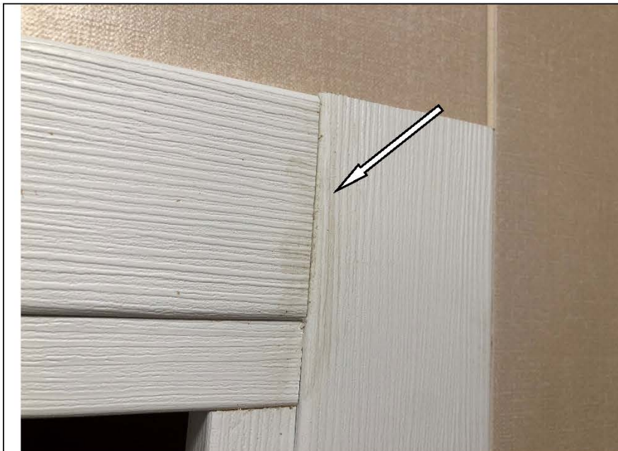
Фото №64. Загрязнение наличника деревянного дверного блока в санузле в квартире.
