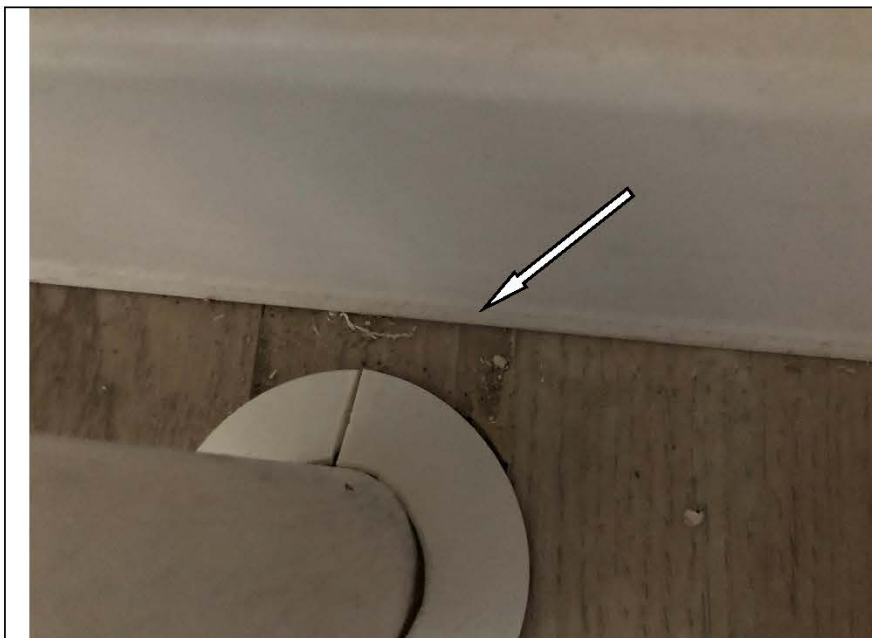
Фото №67. Дефект вставки труб отопления в напольное покрытие из ламината в кухне в квартире.
