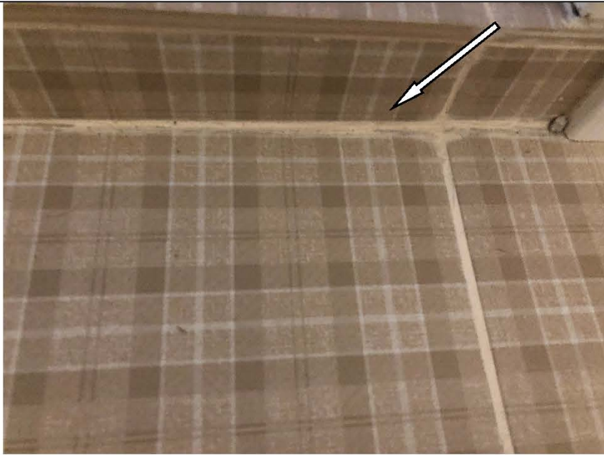
Фото №58. Неровный шов напольной керамической плитки в ванной комнате в квартире.
