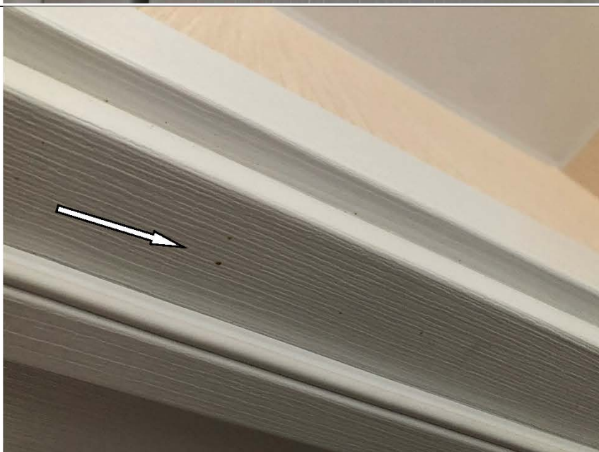
Фото №18. Загрязнение коробки деревянного дверного блока в спальне в квартире.
