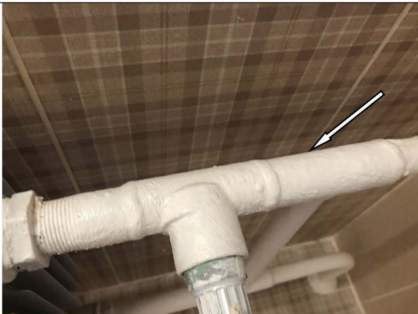
Фото №43. Неровности, сколы на окрашенных трубах отопления в ванной комнате в квартире.
