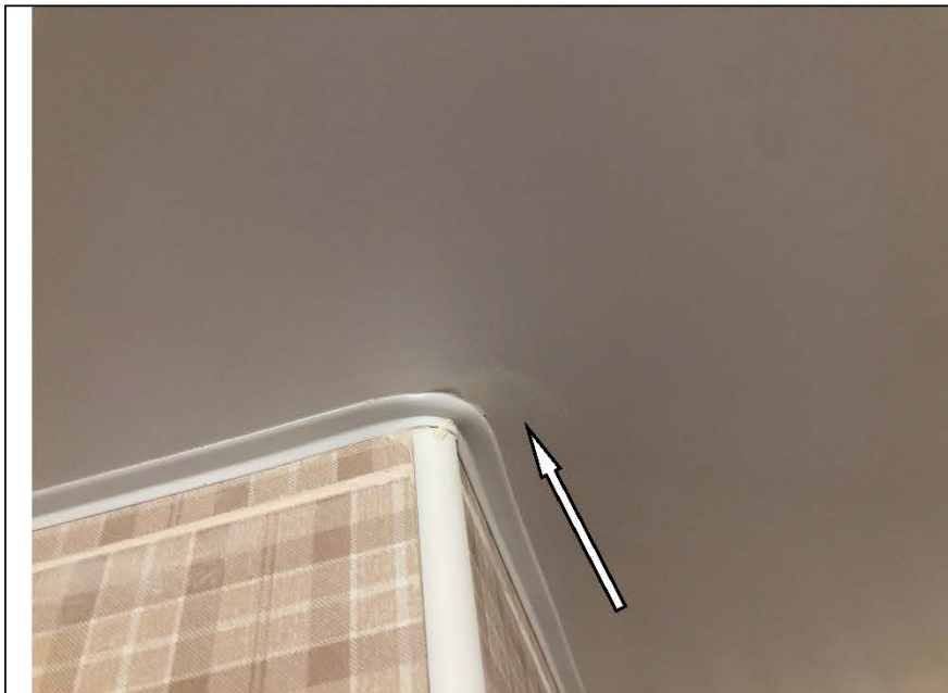
Фото №22. Загрязнение натяжного потолка в ванной комнате в квартире.
