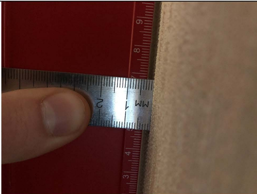
Фото №11. Измерение стен коридора в квартире.
