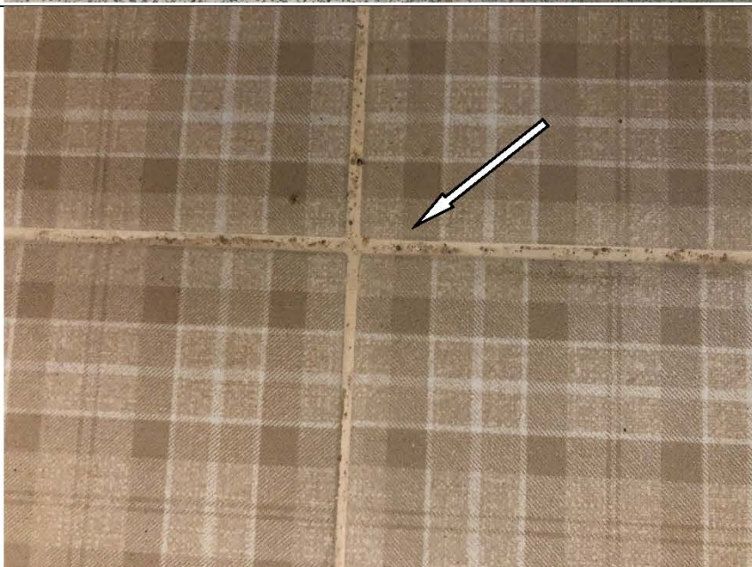
Фото №60. Неровный шов напольной керамической плитки в санузле в квартире.
