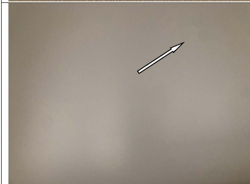
Фото №24. Загрязнение натяжного потолка в кухне в квартире.
