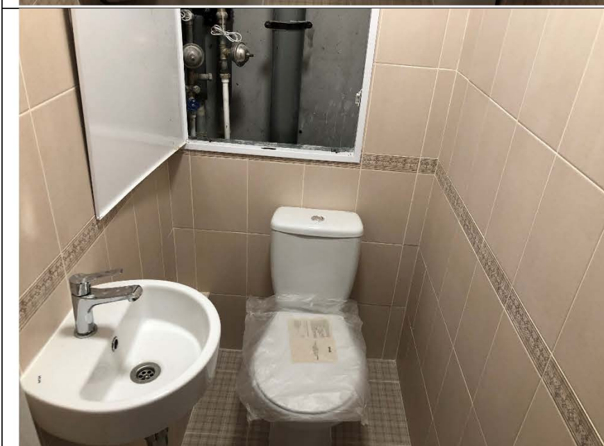
Фото №6. Общий вид санузла в квартире.
