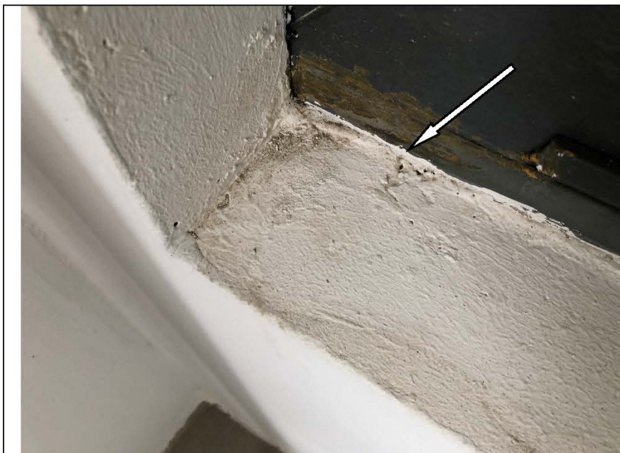
Фото №40. Неровности, сколы на окрашенных откосах оконного блока ПВХ на лоджии в квартире.
